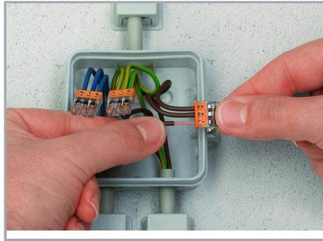
Anschließen: Abisolierten eindrätigen Leiter bis zum Anschlag einstecken.
